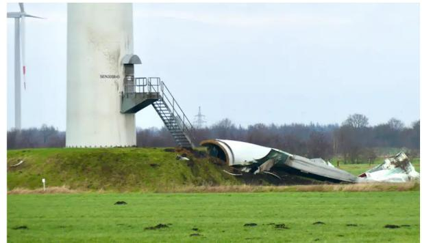
Abgestürztes Rohrblatts einer Windkraftanlage in Stieglund im Kreis Schleswig-Flensburg. FOTO: ALEXANDER KUHN
